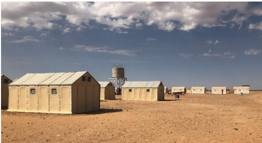
Photo 1 : Maison préfabriquée sur le centre humanitaire – REACH, Décembre 2018
